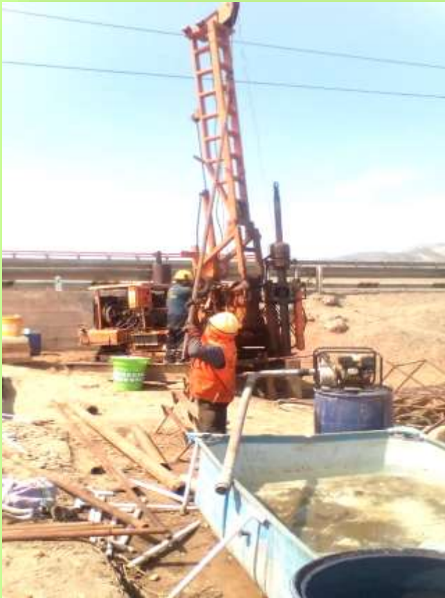
PERFORACIONES DE SPT CON RECUPERACIÓN DE MUESTRA
